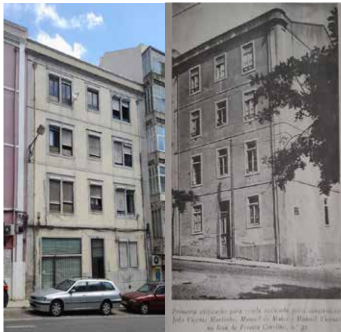
1º Prédio construído no ano de 1906 (ao que consta) na R. Pereira de Carrilho 32 ( Arroios)
